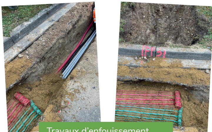
Travaux d'enfouissement des réseaux rue de l'Ironpha
